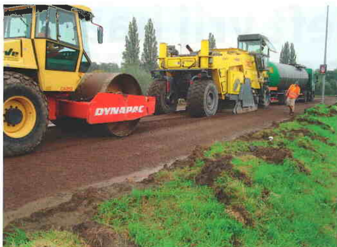
Mengen en verdichten van de 'nieuwe' fundering van hergebruikt lava.
