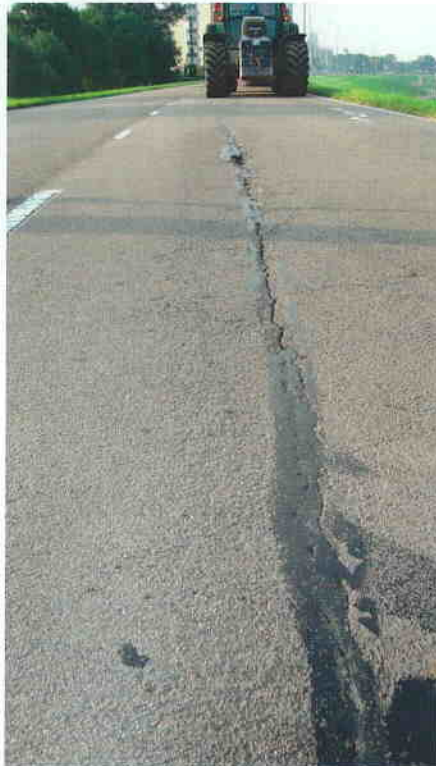
De verharding van de Ringdijk in Zwijndrecht is 'op'.
