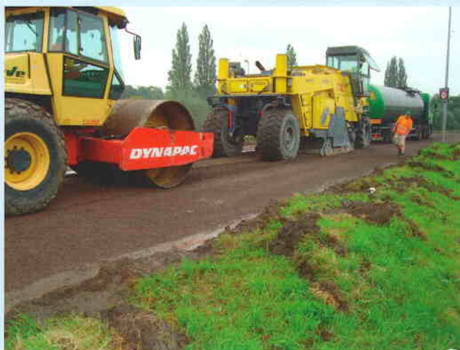
Mengen en verdichten.
