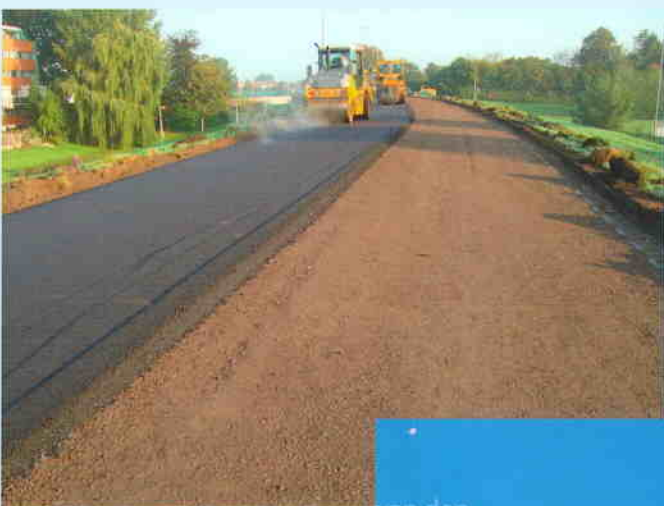
Aanbrengen asfalt op lava.
