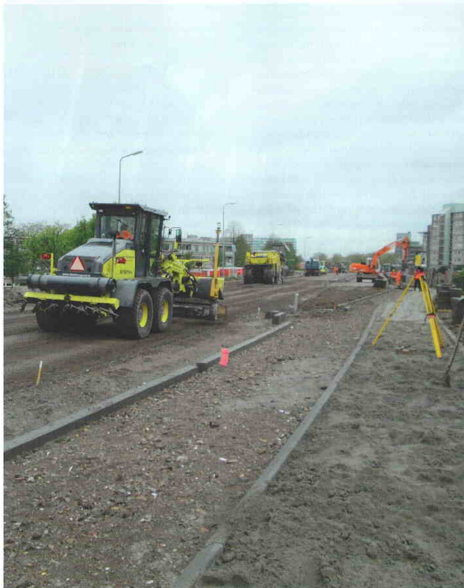
Oude lavafunderingen zijn na de juiste bewerking goed te hergebruiken.
